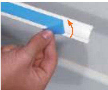
1 Simplemente remover el protector del adhesivo de la minicanaleta.
