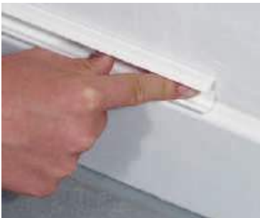
1 Colocar la minicanaleta sobre la pared.
